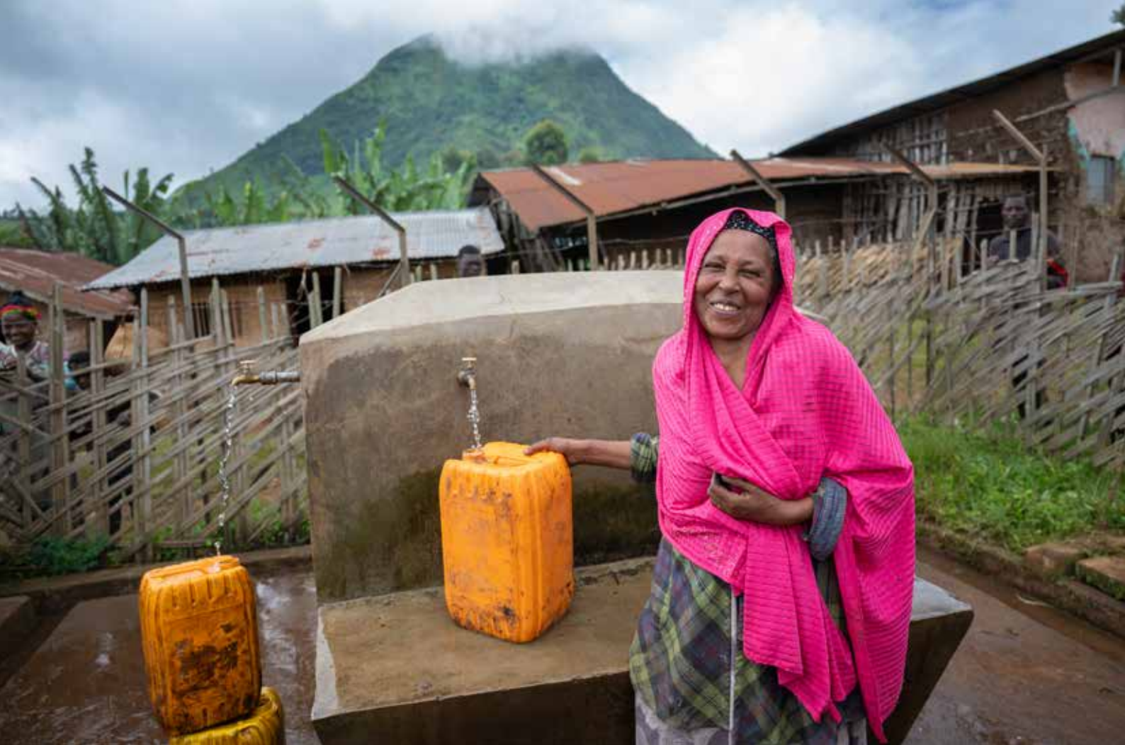
Vannsystem i landsbyen Woset utenfor Jinka i Etiopia. Prosjektet er finansiert av selskapet Knorr Bremse, som Kirkens Nødhjelp implementerer. Gimja Kassa leder vannkomiteen. FOTO: Håvard Bjelland / Kirkens Nødhjelp.
